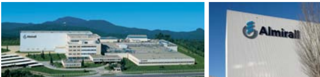
Production plant in Sant Andreu de la Barca (Barcelona)
